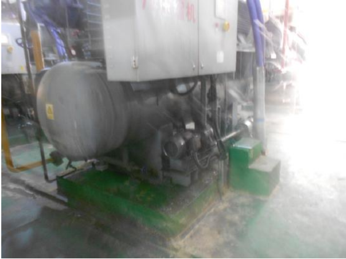
空压机设备底座减振等
