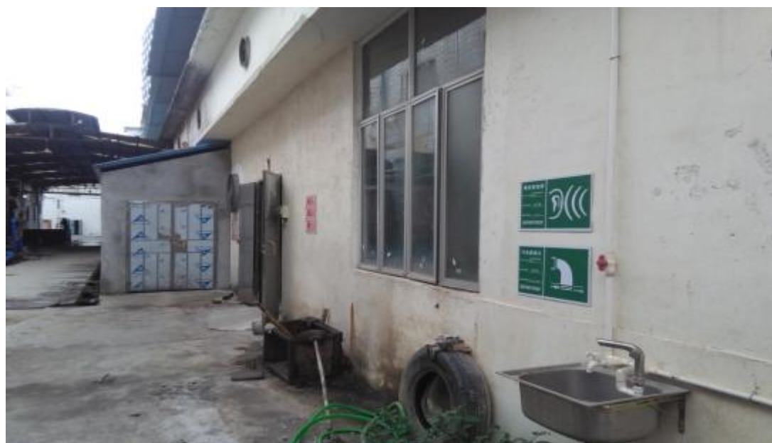
WS-01 废水排放口、ZS-01 设备噪声排放
