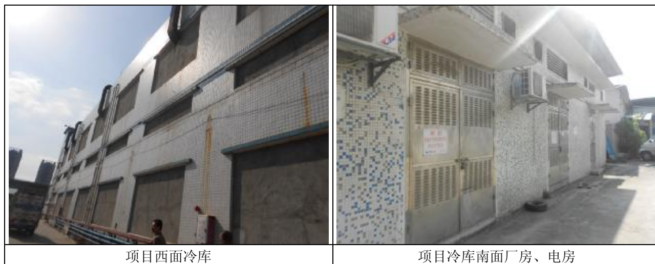
图 3.3-4 建设项目及周边情况照片
