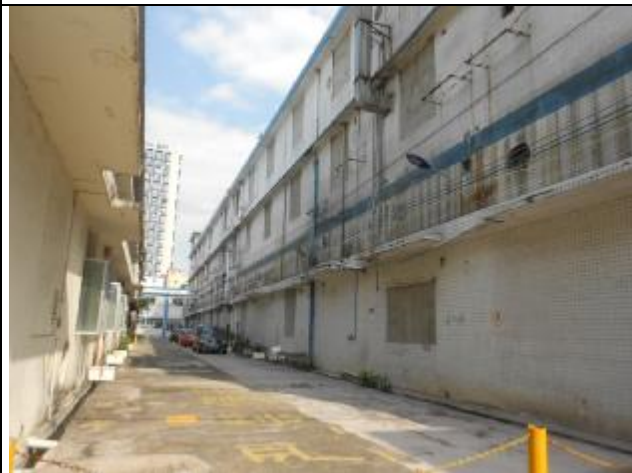
机房南面工业厂房
