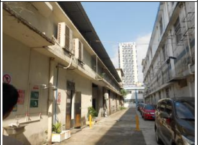
项目东面工业厂房
