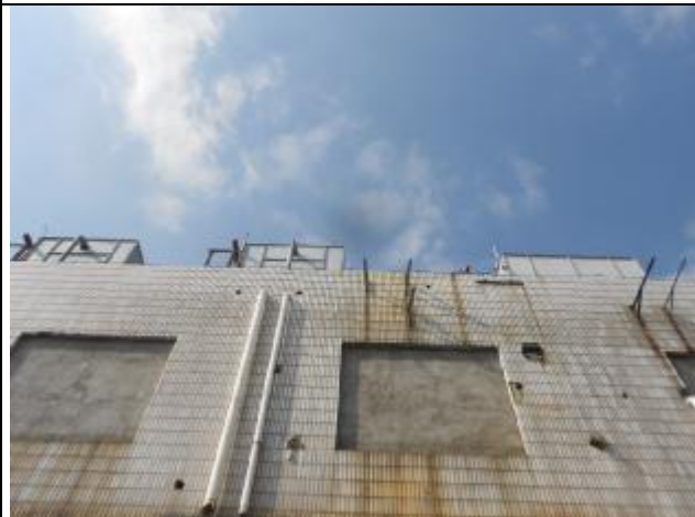
项目制冰车间所在厂房
