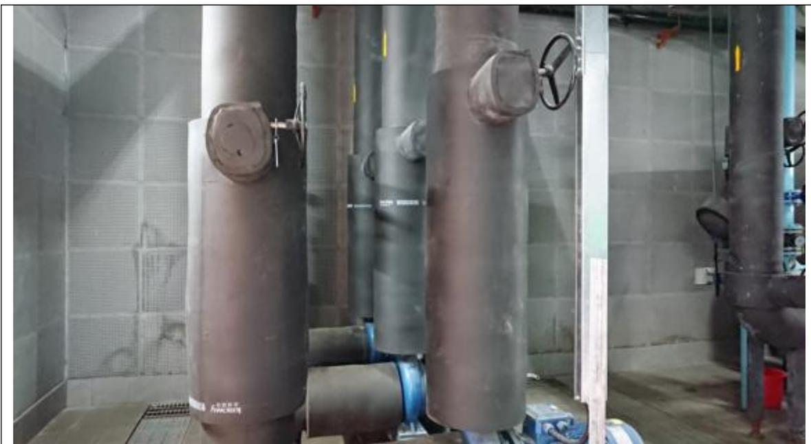
中央空调水冷螺杆式机组机房吸声及减振
