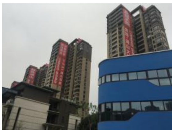
金地山湖城（一期）307号住宅楼
