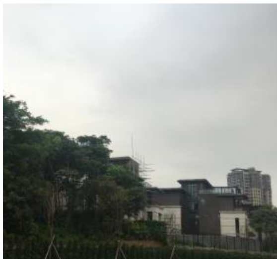
金地山湖城（一期）102号~104号住宅楼
