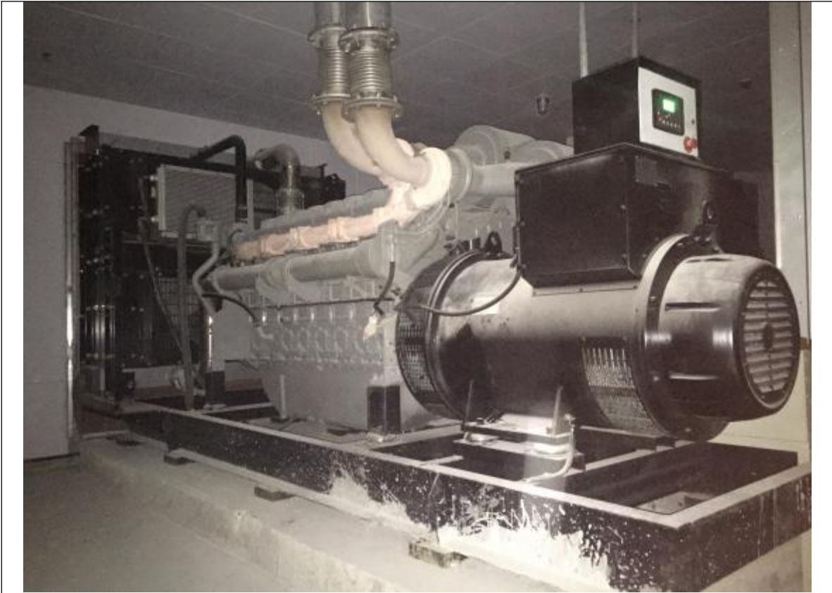
发电机减震、吸声设施
