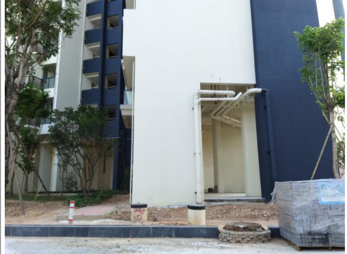
项目污水排放口
