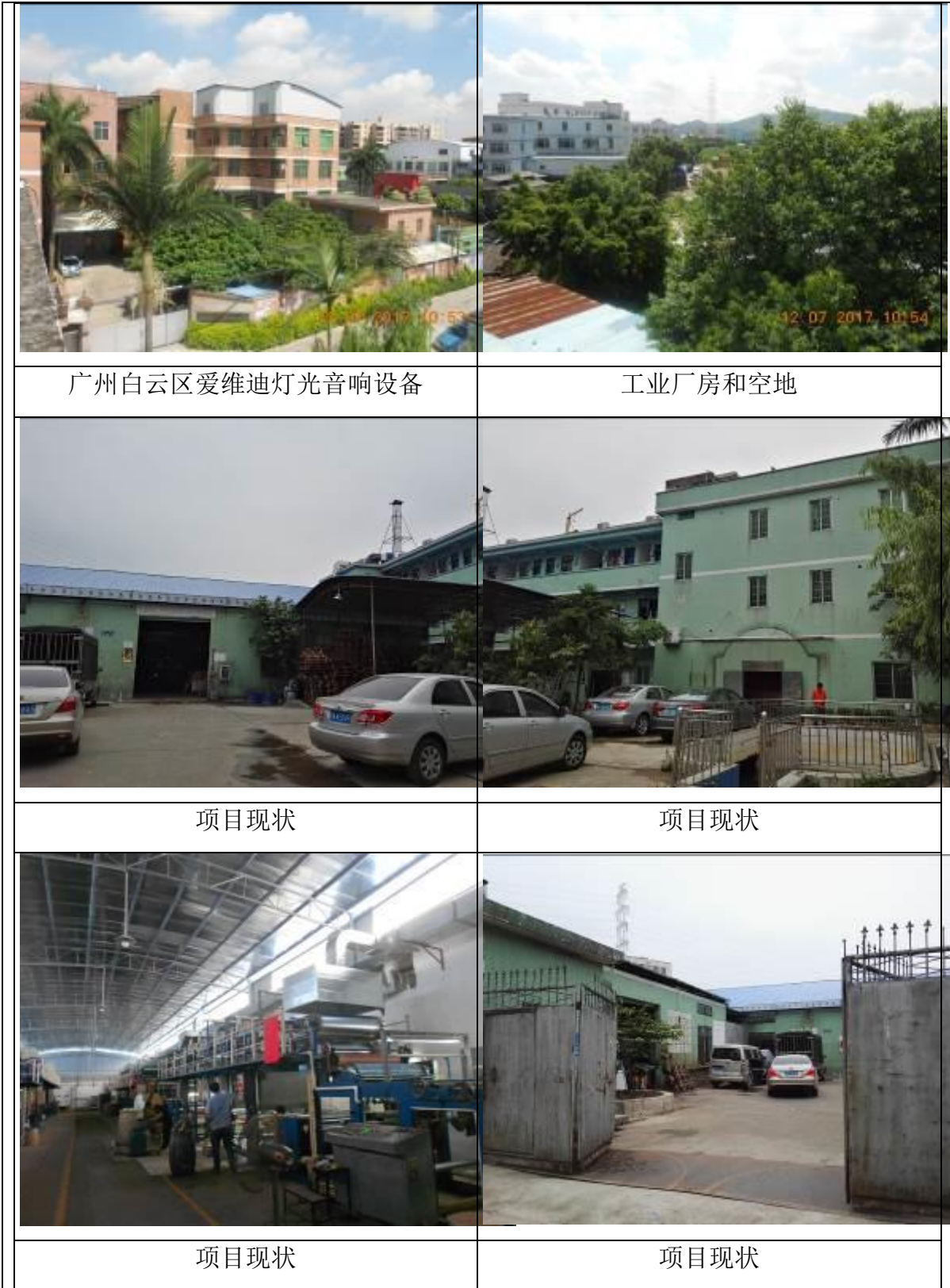
图 2-3 项目及周边情况照片
