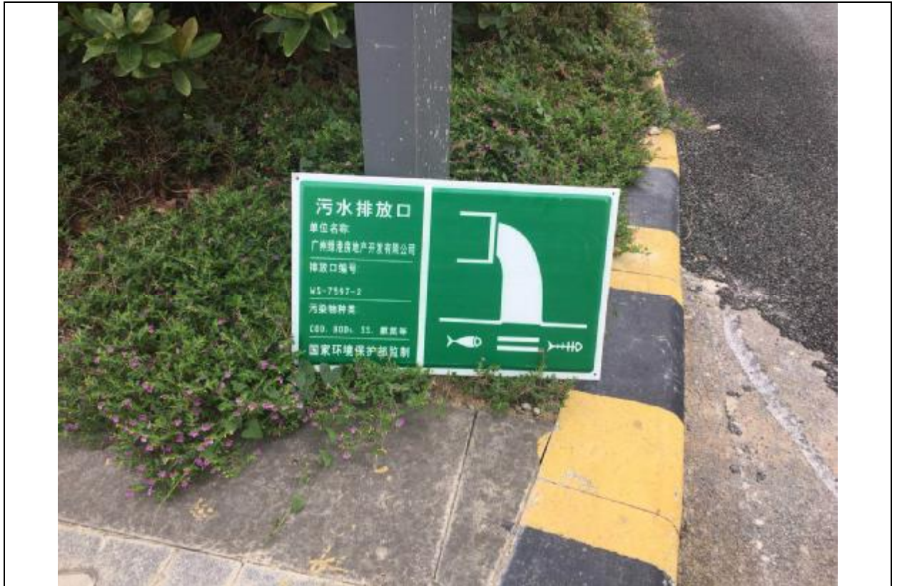
污水排放口（近照）
