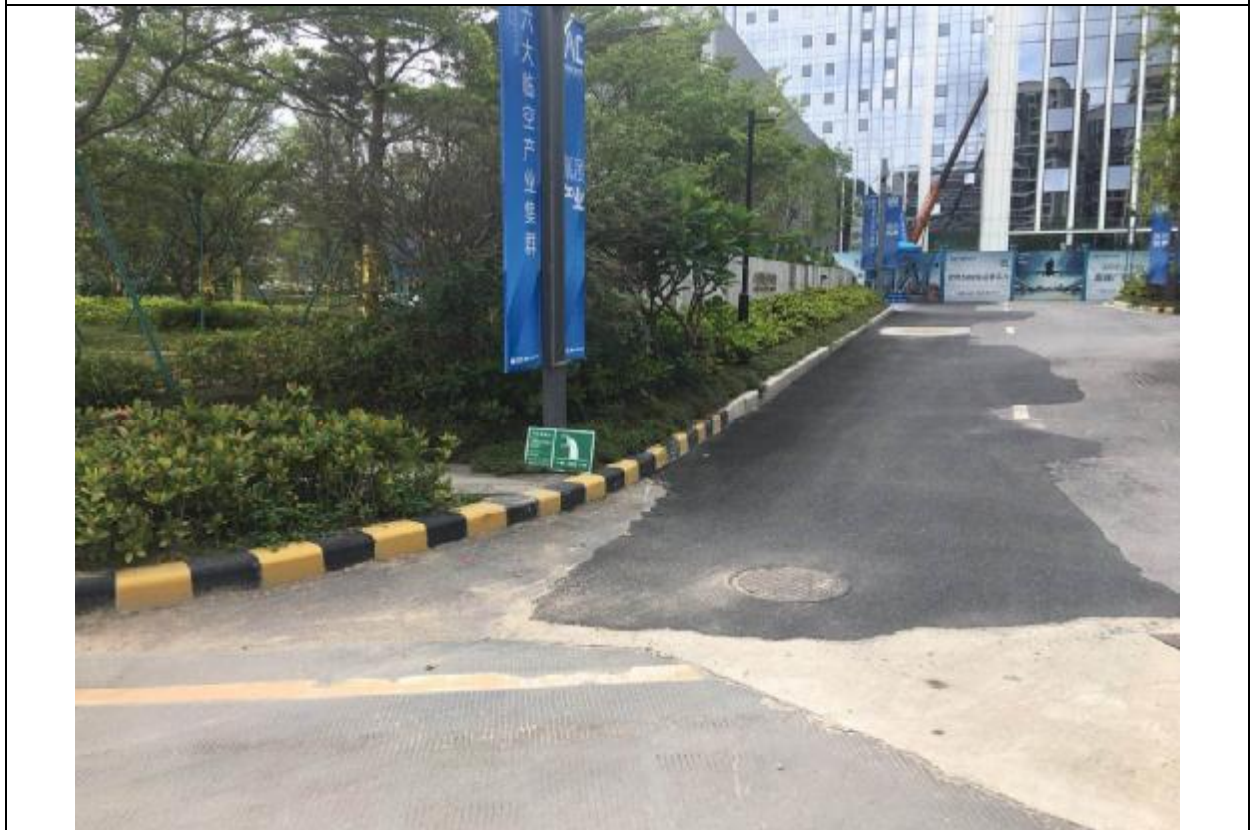
污水排放口（远照）
