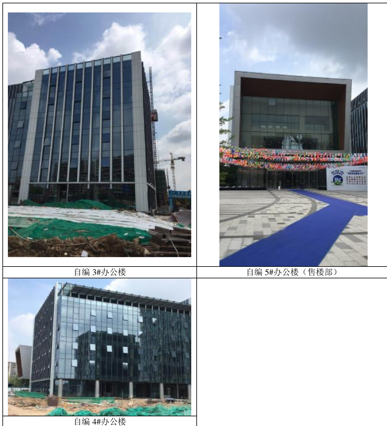
图 3.3-4 建设项目及周边情况照片
