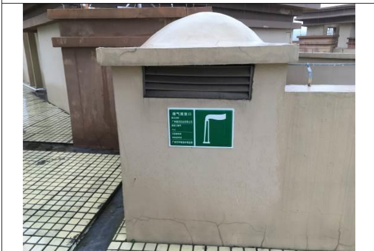
发电机尾气放口：气-01（远照）
