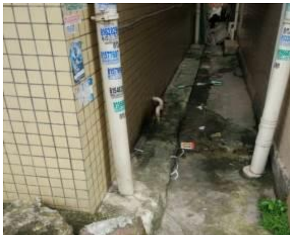
村内排水现状-合流暗渠
