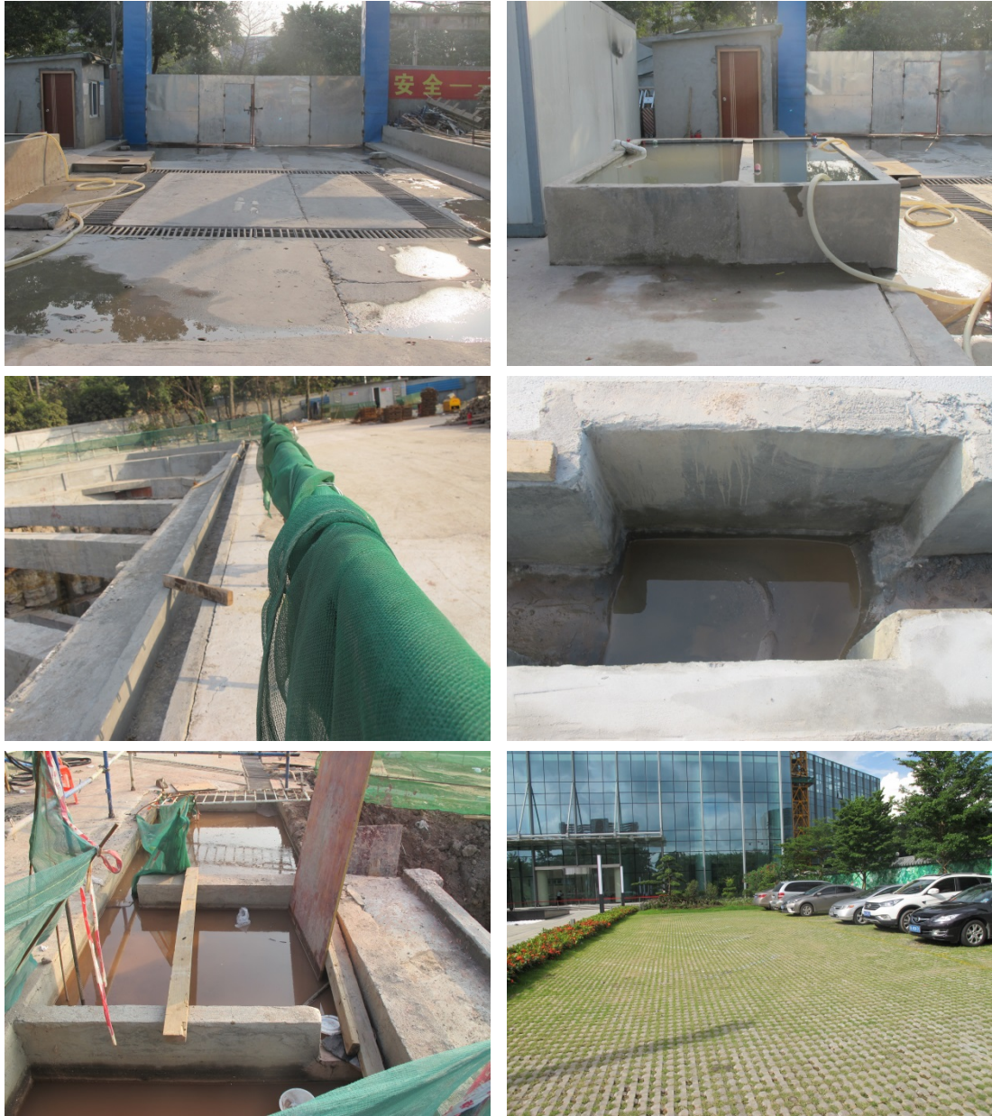
图 4-3 项目区临时措施（已拆除）
