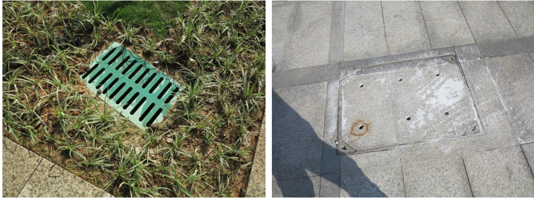
图 4-1 水土保持工程措施现状
