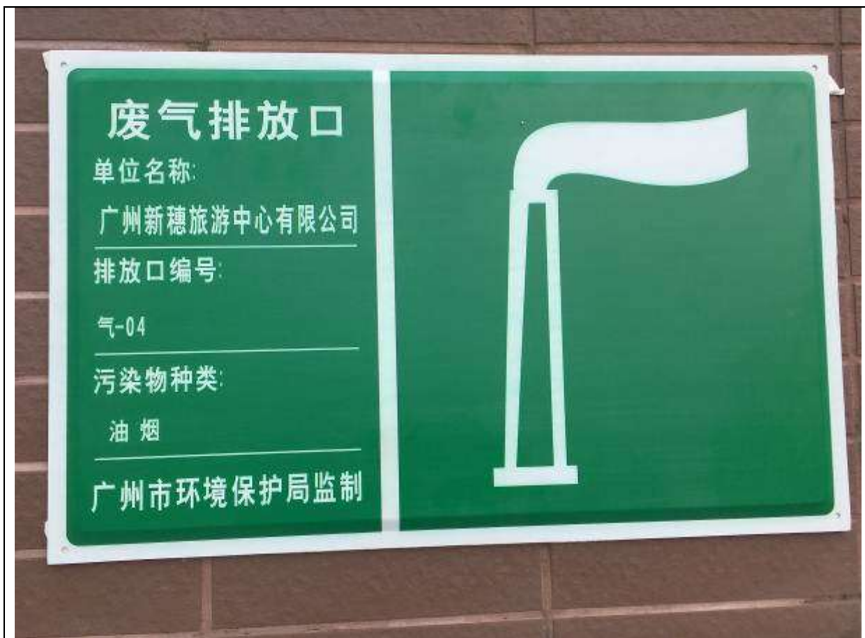
油烟废气排放口：气-04（近照）
