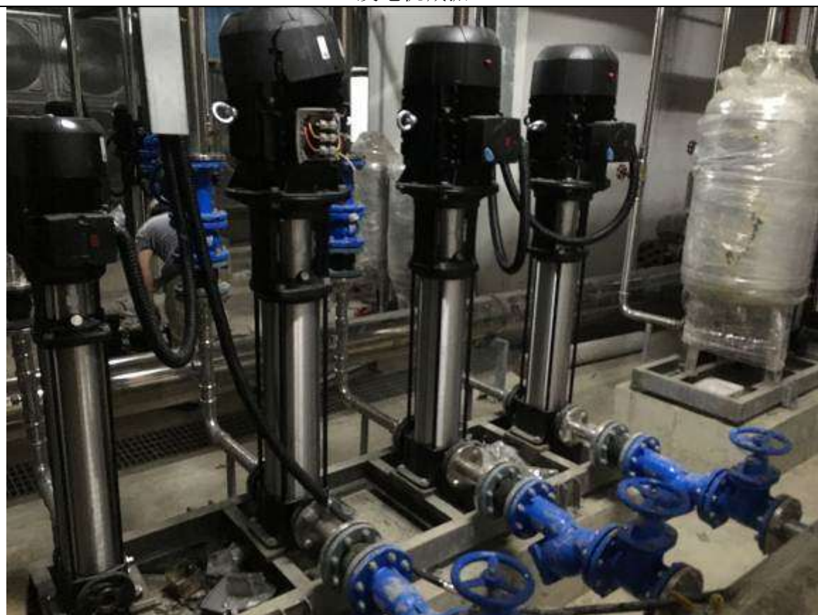
制冷机组减振
