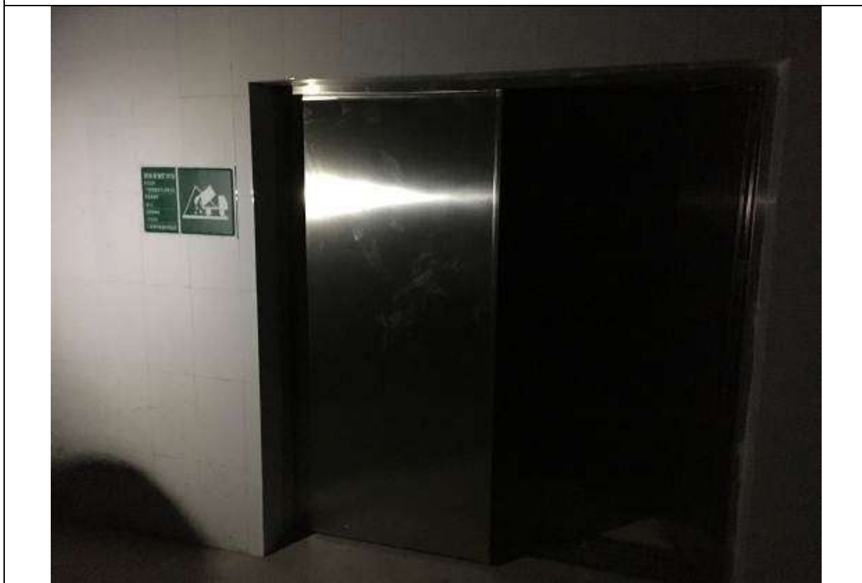
垃圾收集房：固-01（远照）
