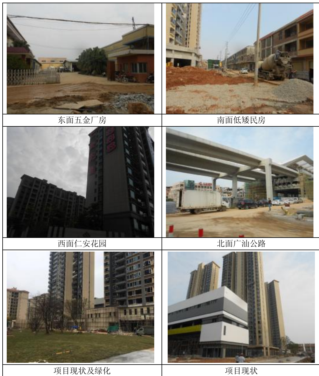
图 3.3-4 建设项目周边情况照片摘选
