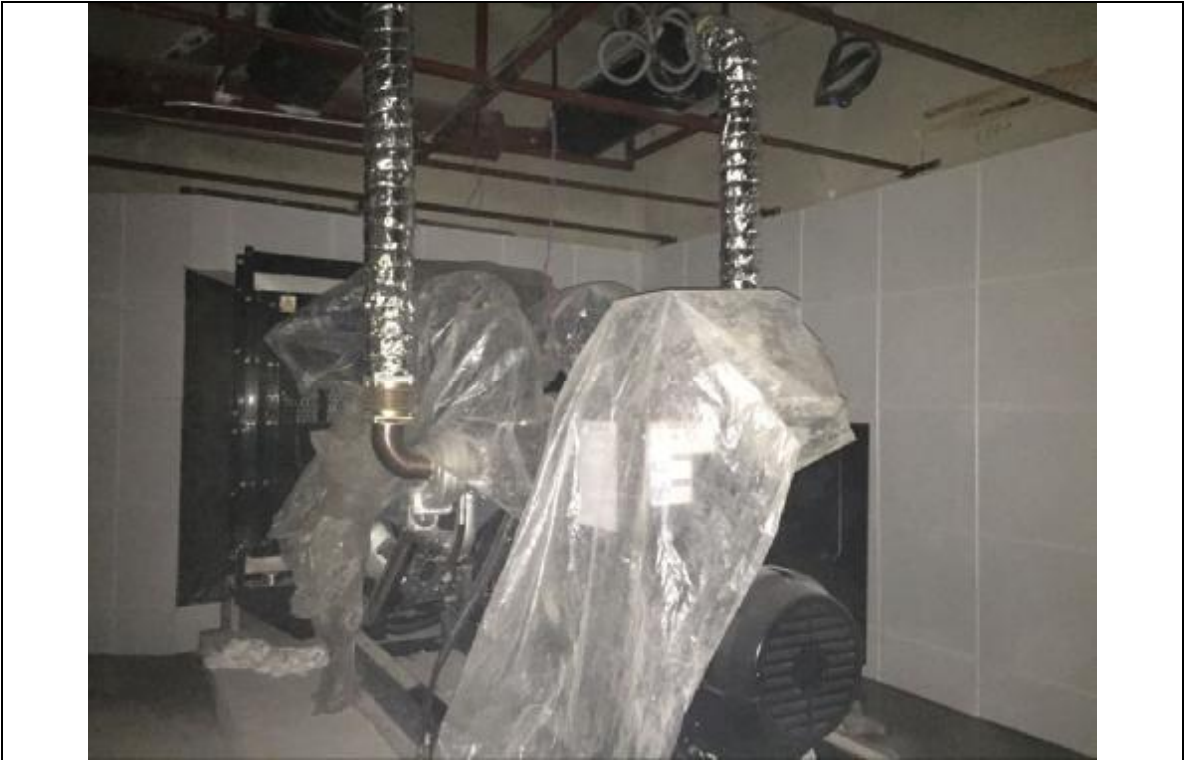
发电机房备用发电机及减振
