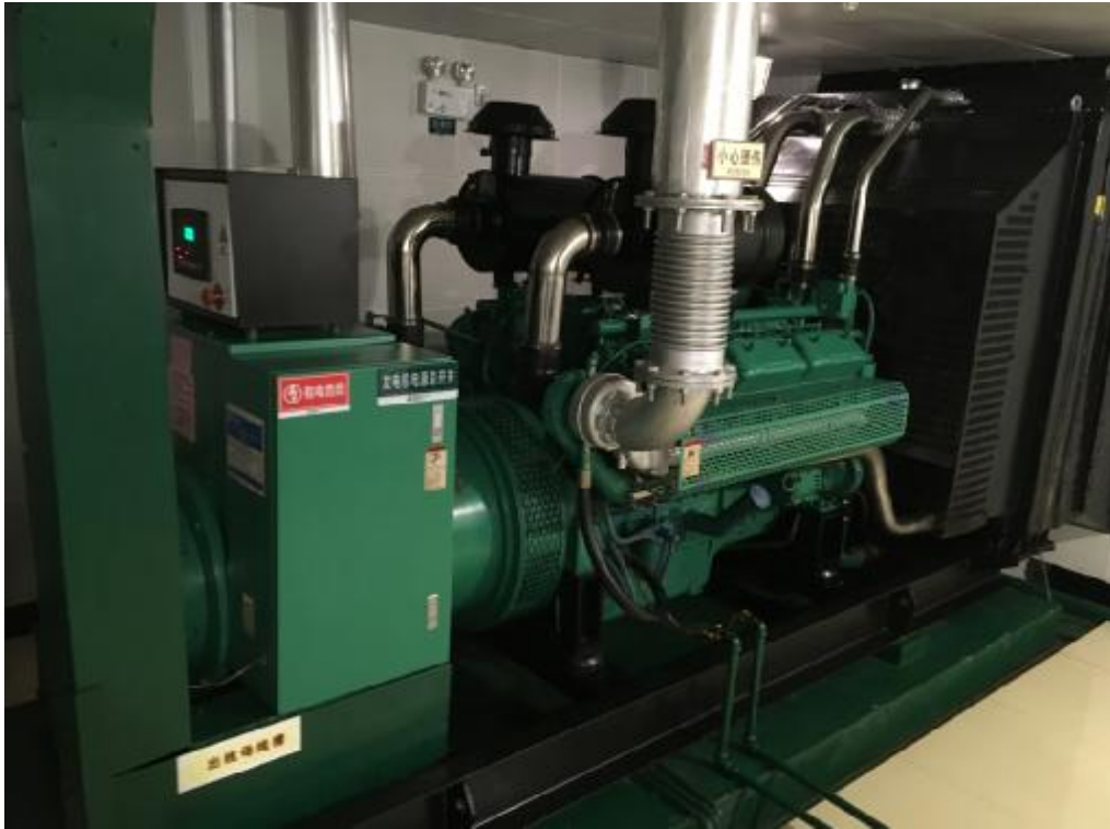
备用发电机及减振示意图
