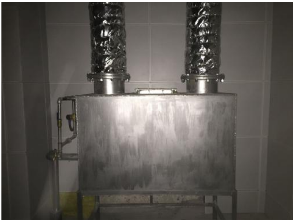
水喷淋装置示意图
