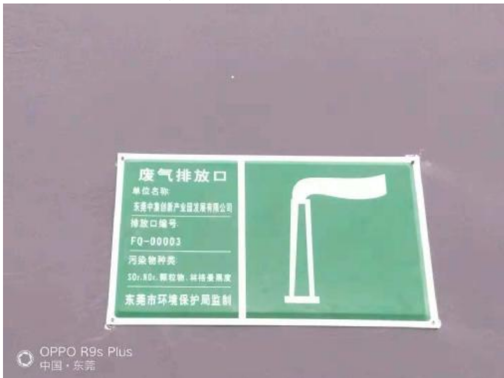
发电机尾气排放口及标志牌（近）
