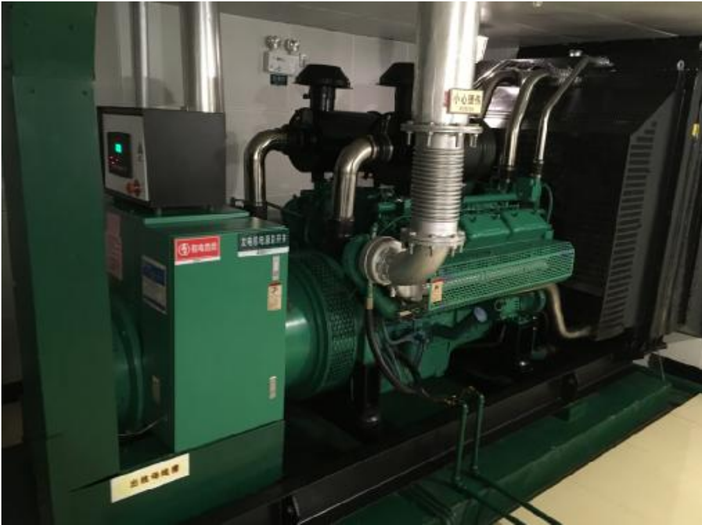
备用发电机及减振示意图
