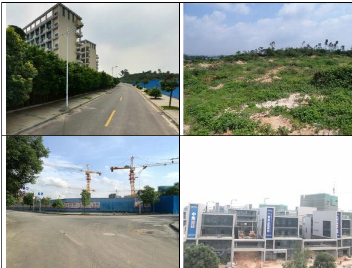
图 3.3-3 建设项目周边情况照片
