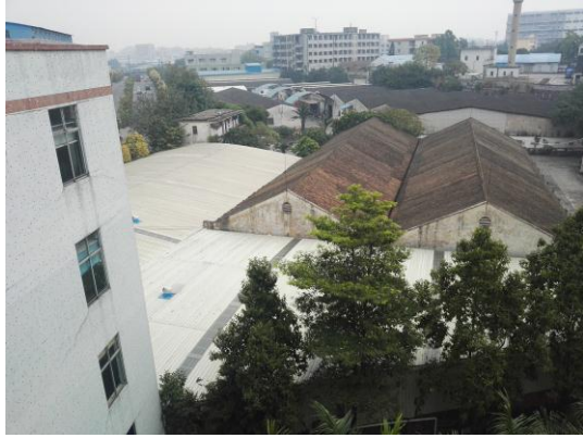
项目东面：仓库
