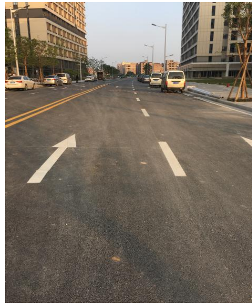
项目北侧代建道路
