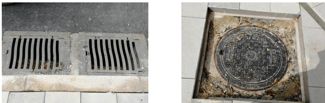
图4.1-1 水土保持工程措施现状
