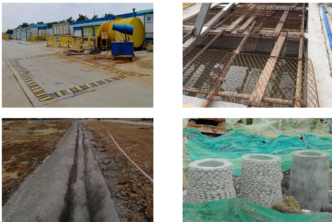
图4.3-1 水土保持临时措施
