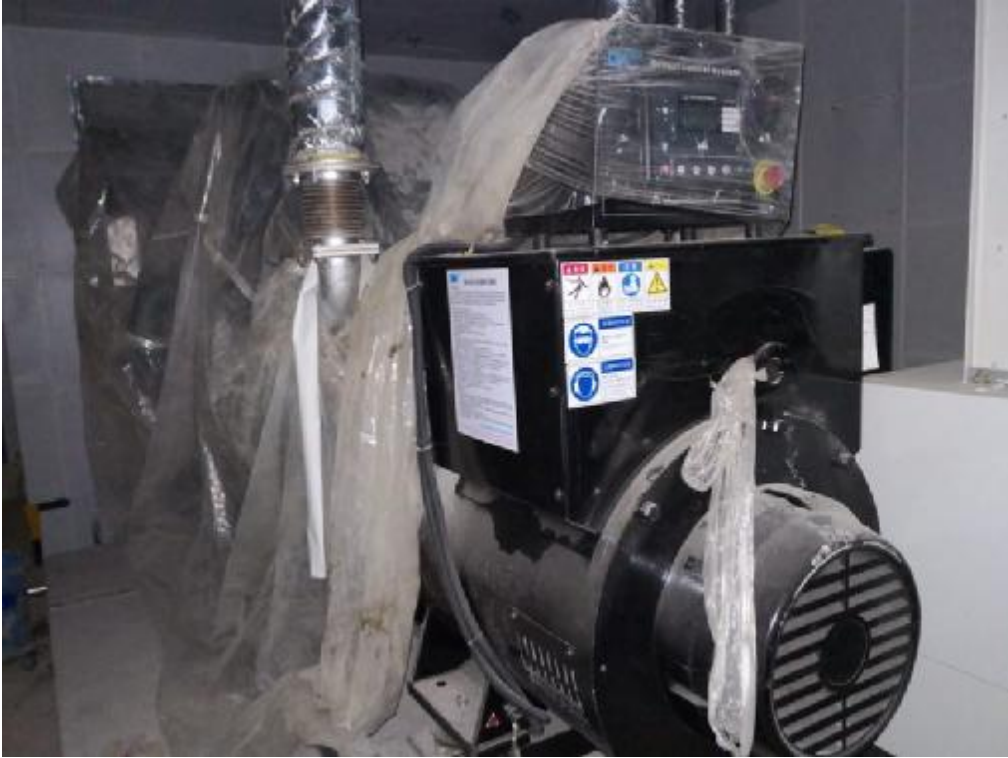
备用发电机及减振示意图
