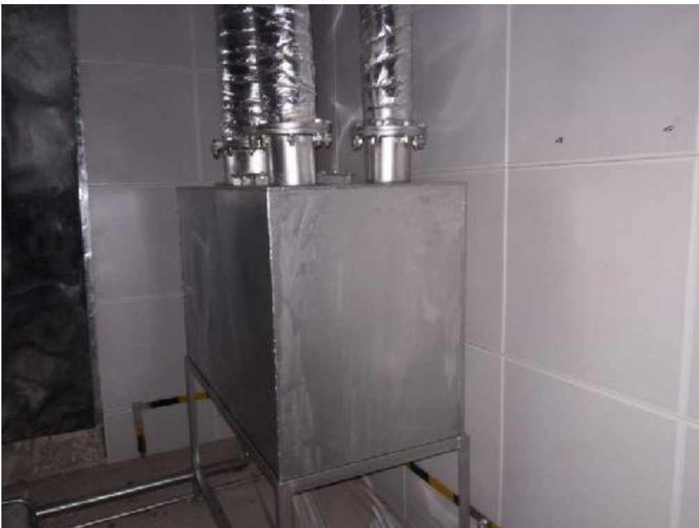
水喷淋装置示意图
