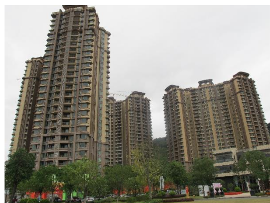
一期主体工程
