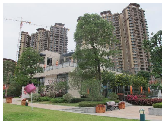
一期主体工程
