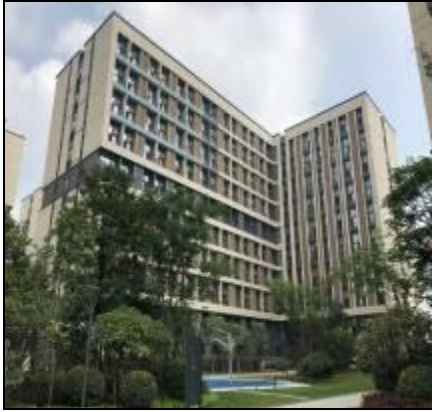
附件 7 项目水土保持相关照片
