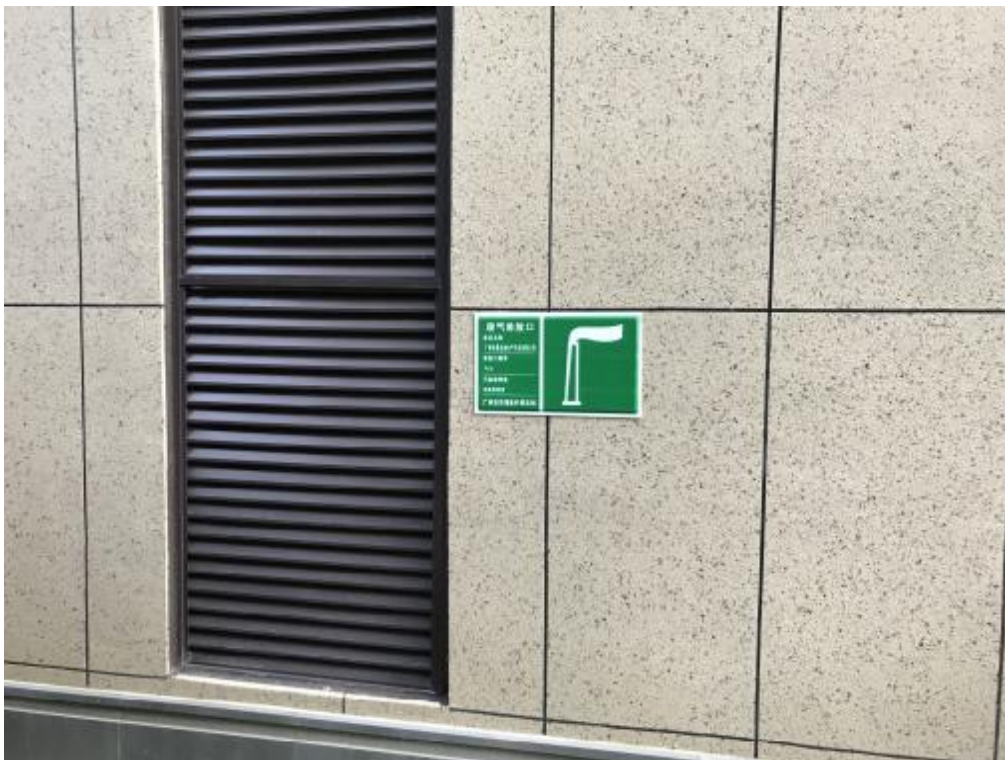
气-01 发电机尾气排放口
