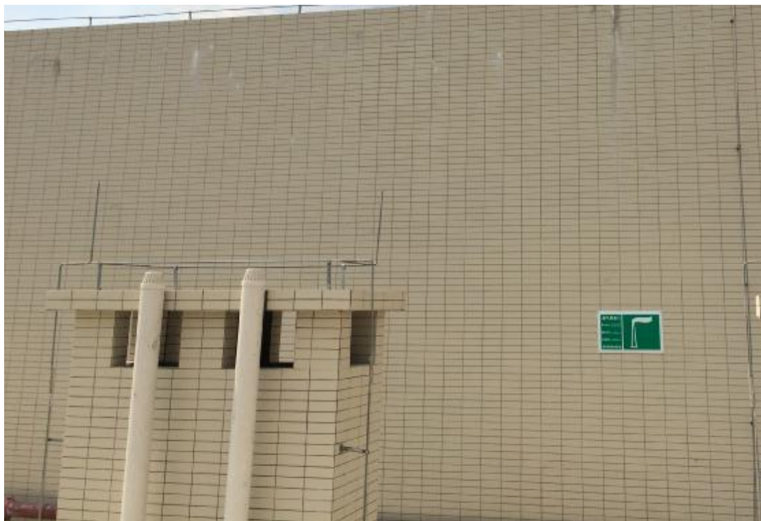
气-03 食堂油烟排放口
