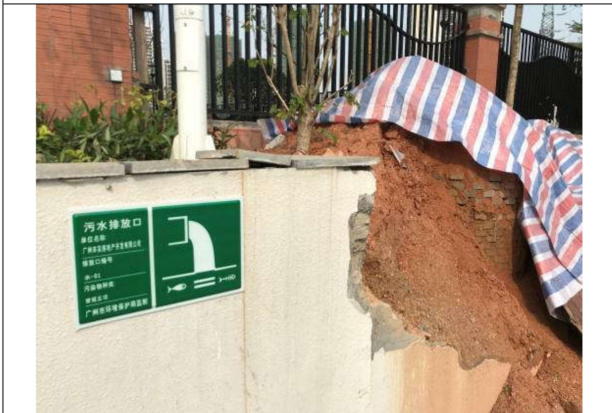
污水排放口：水-01（远照）
