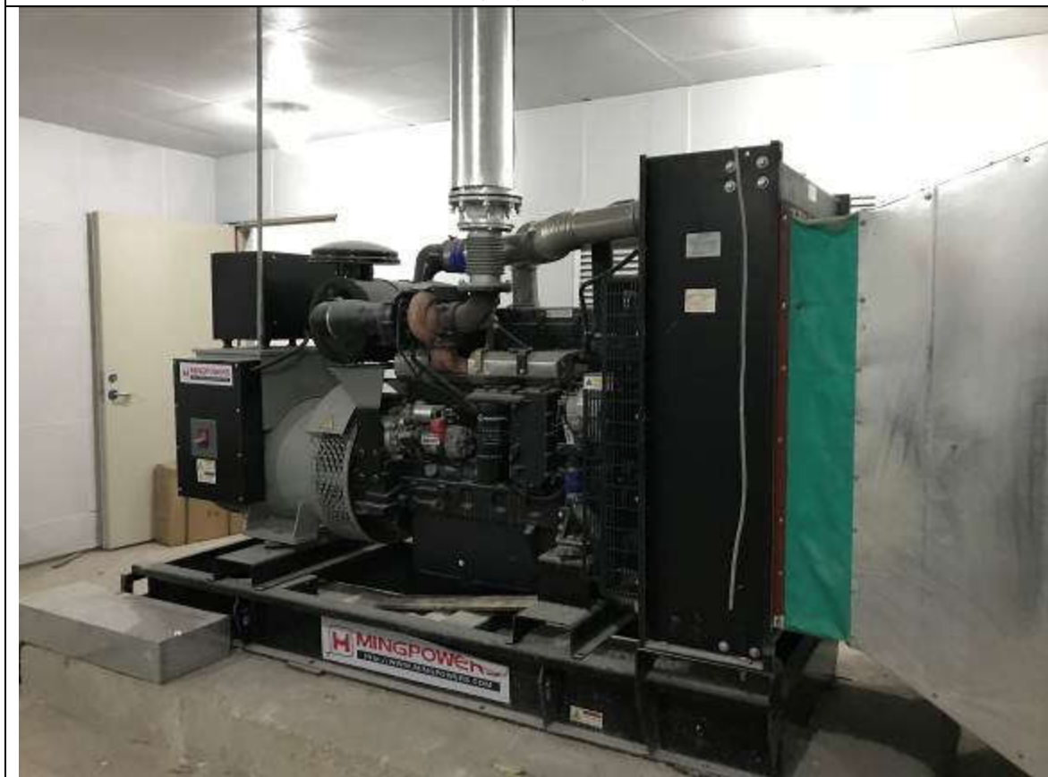
发电机房吸声、减振、排烟管
