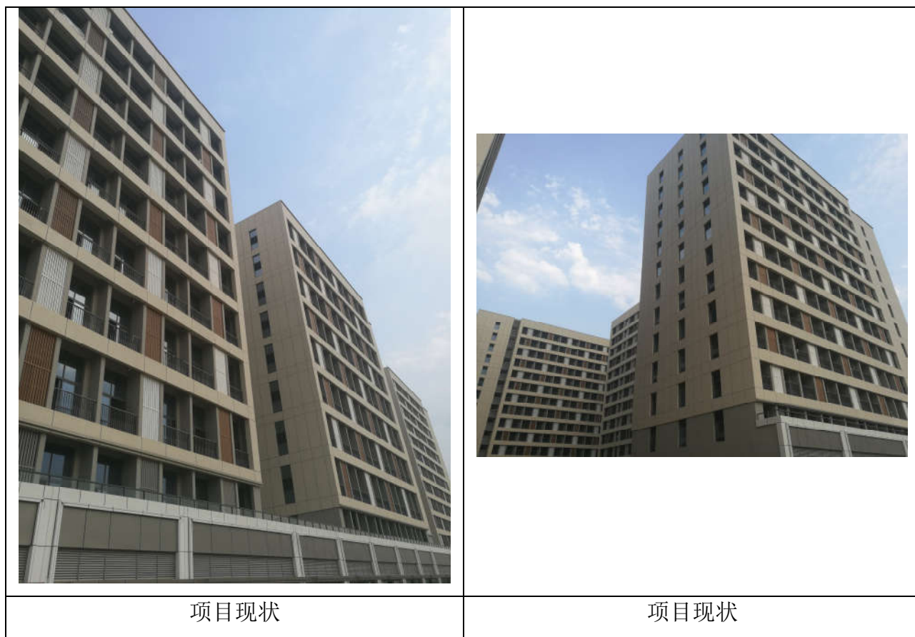
图 3.3-2 建设项目及周边情况照片
