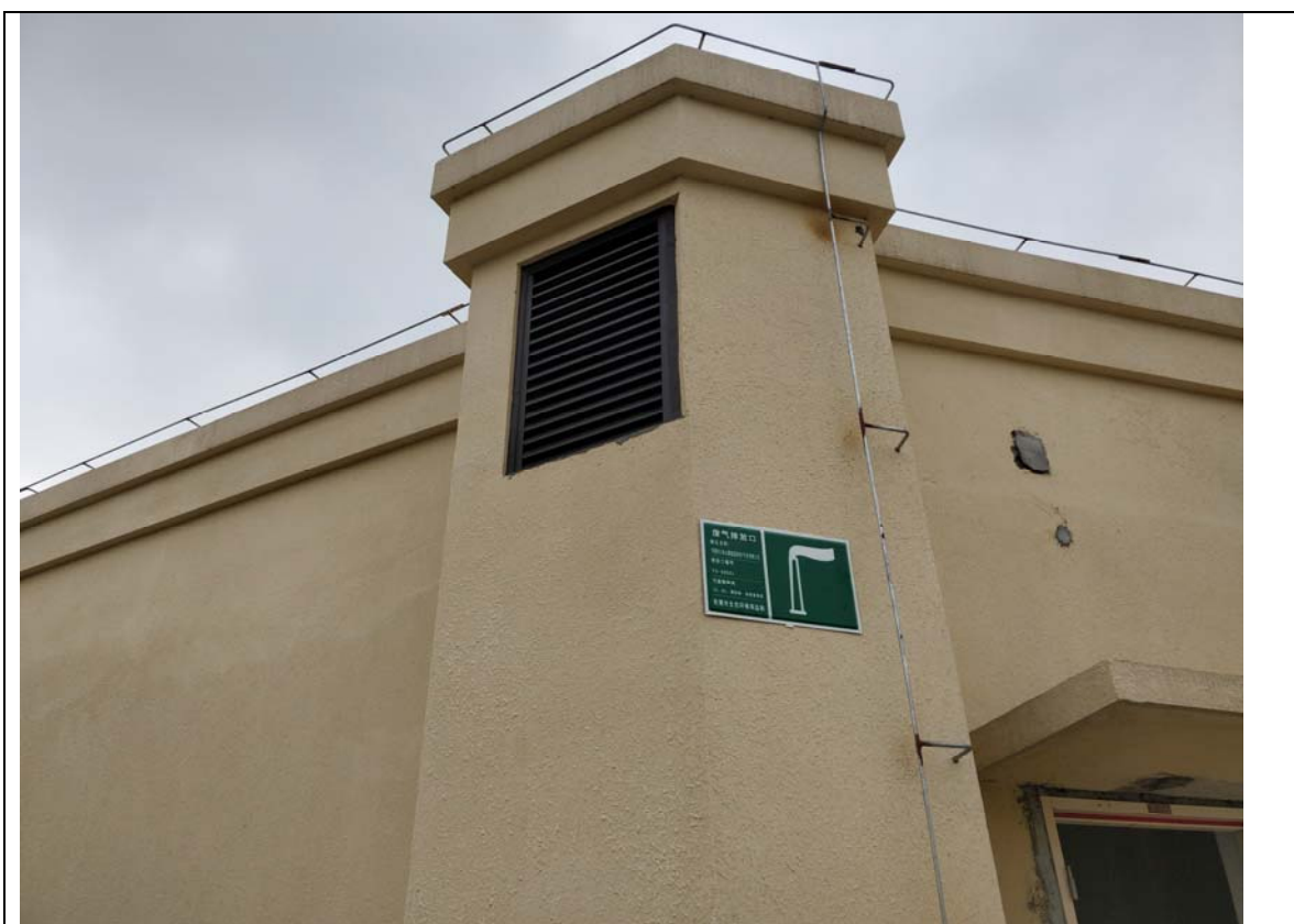
发电机废气排放口：FQ-00001
