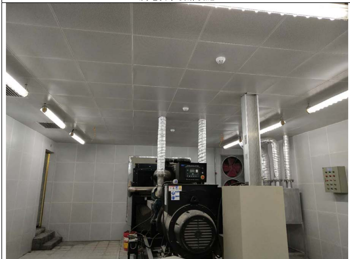
发电机房吸声墙
