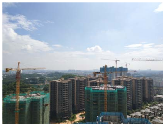
东北面: 施工工地
