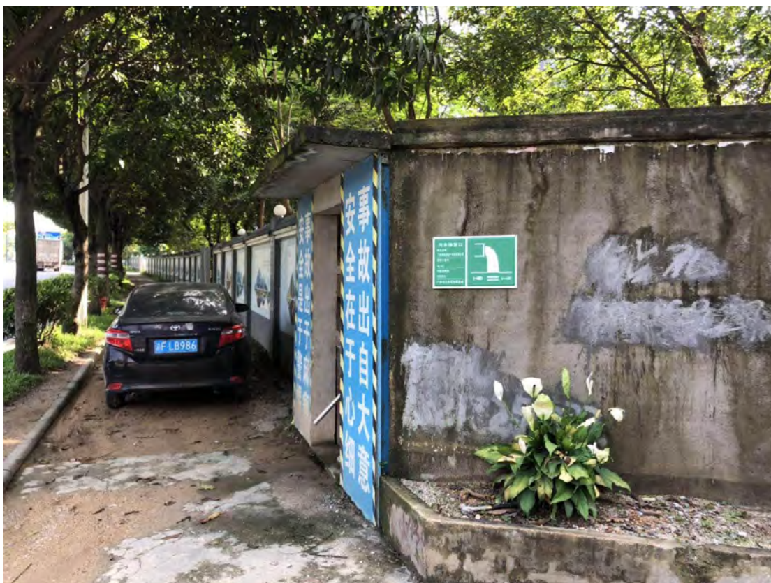
污水排放口：水-02（远照）
