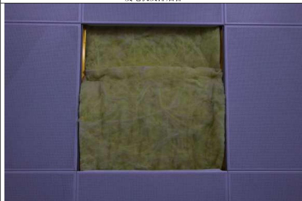
发电机房隔声墙
