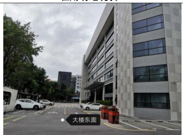
所在建筑东面
