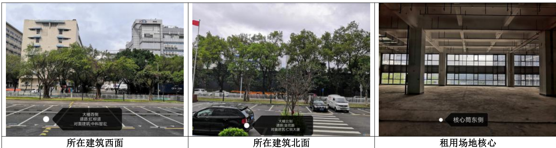
附图 5 项目租用建筑及周边现状情况
