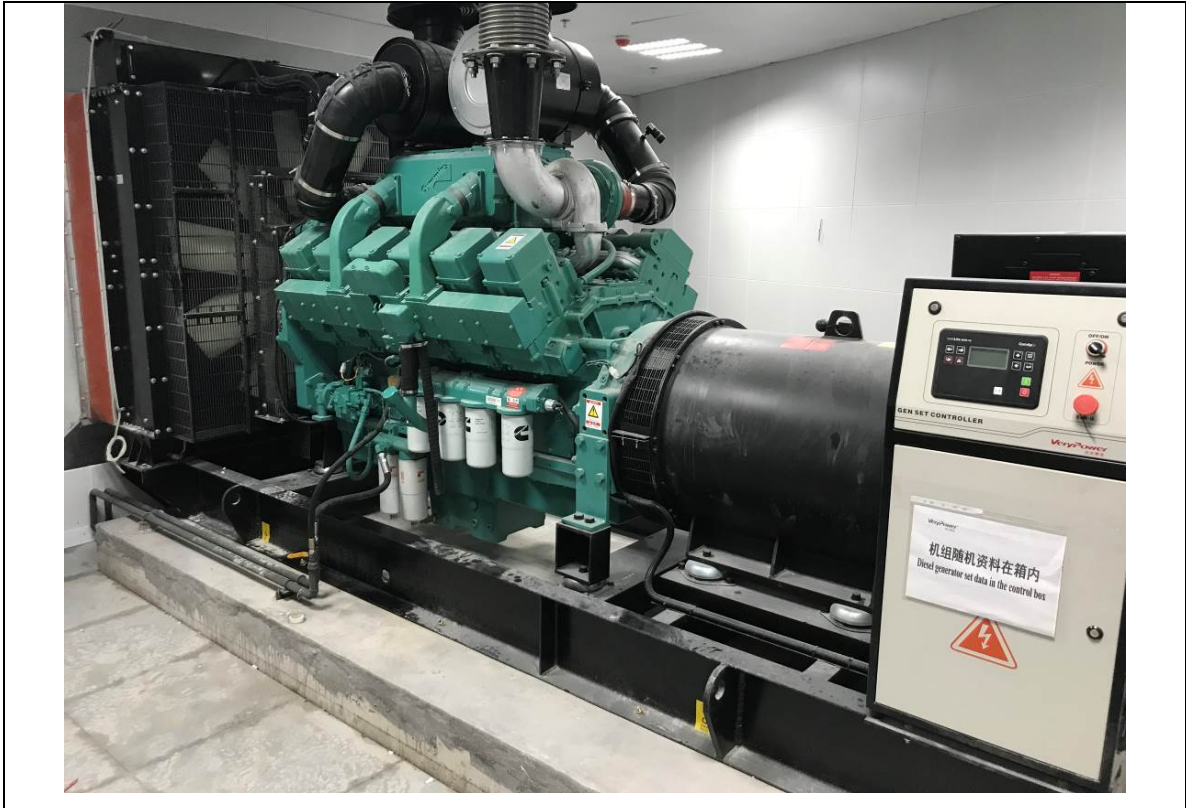
发电机及减振、隔声墙
