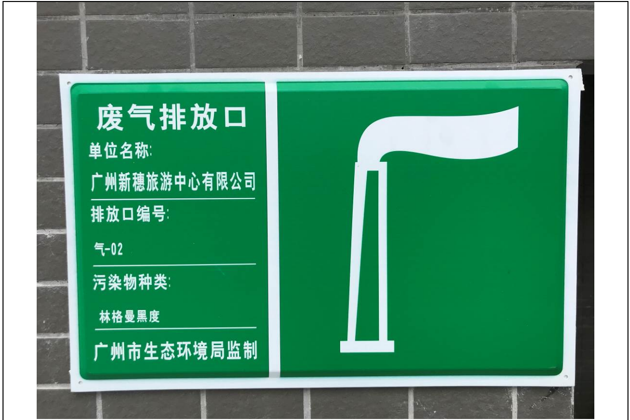
发电机尾气排放口：气-02（近照）
