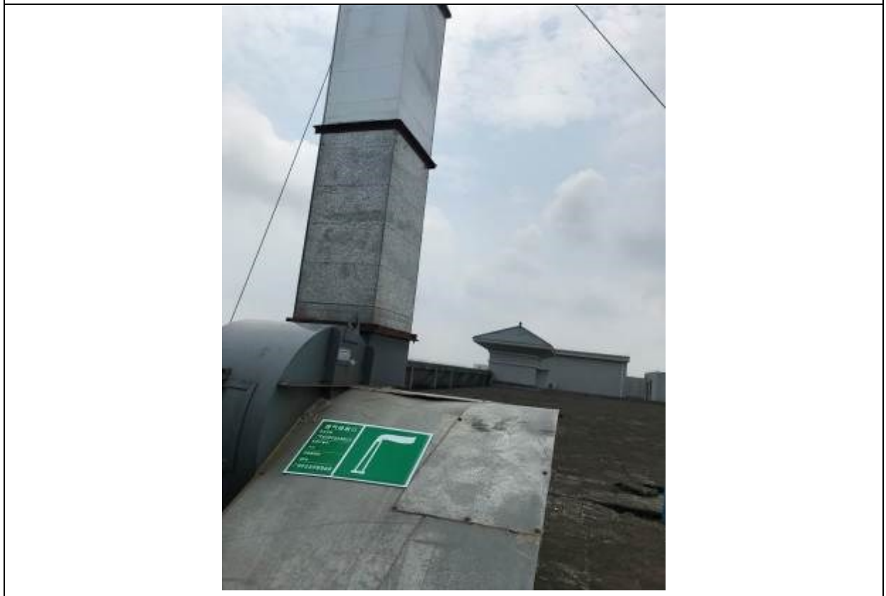
粉尘废气排放口：气-02（远照）
