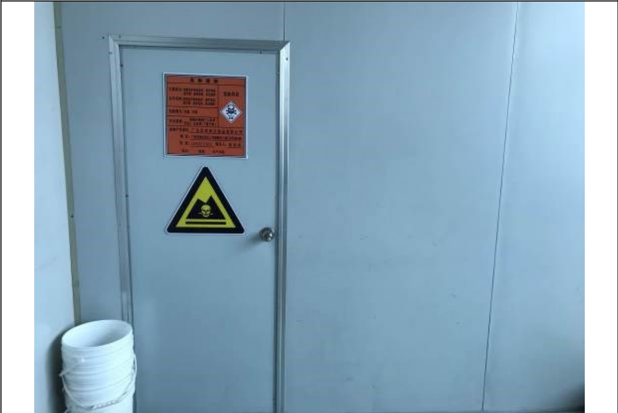
危废暂存间（远照）
