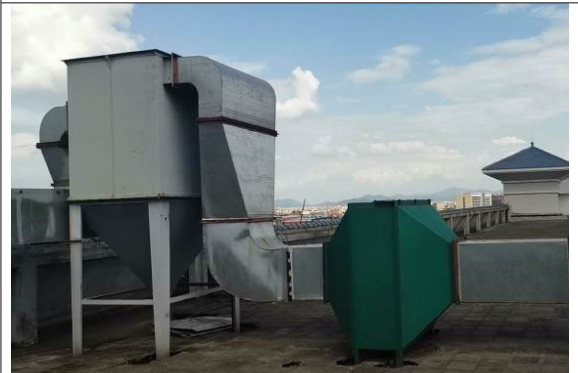
多管除尘器、干式过滤器
