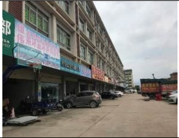
项目东北面：商铺
