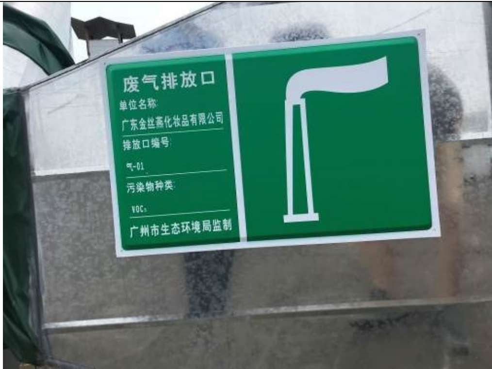
有机废气排放口：气-01（近照）
