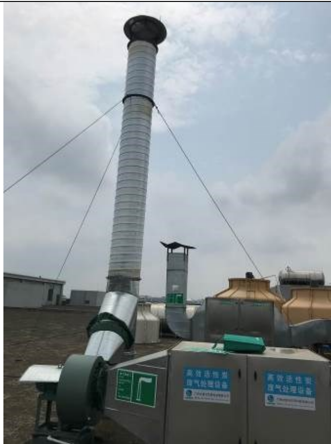
有机废气排放口：气-01（远照）
