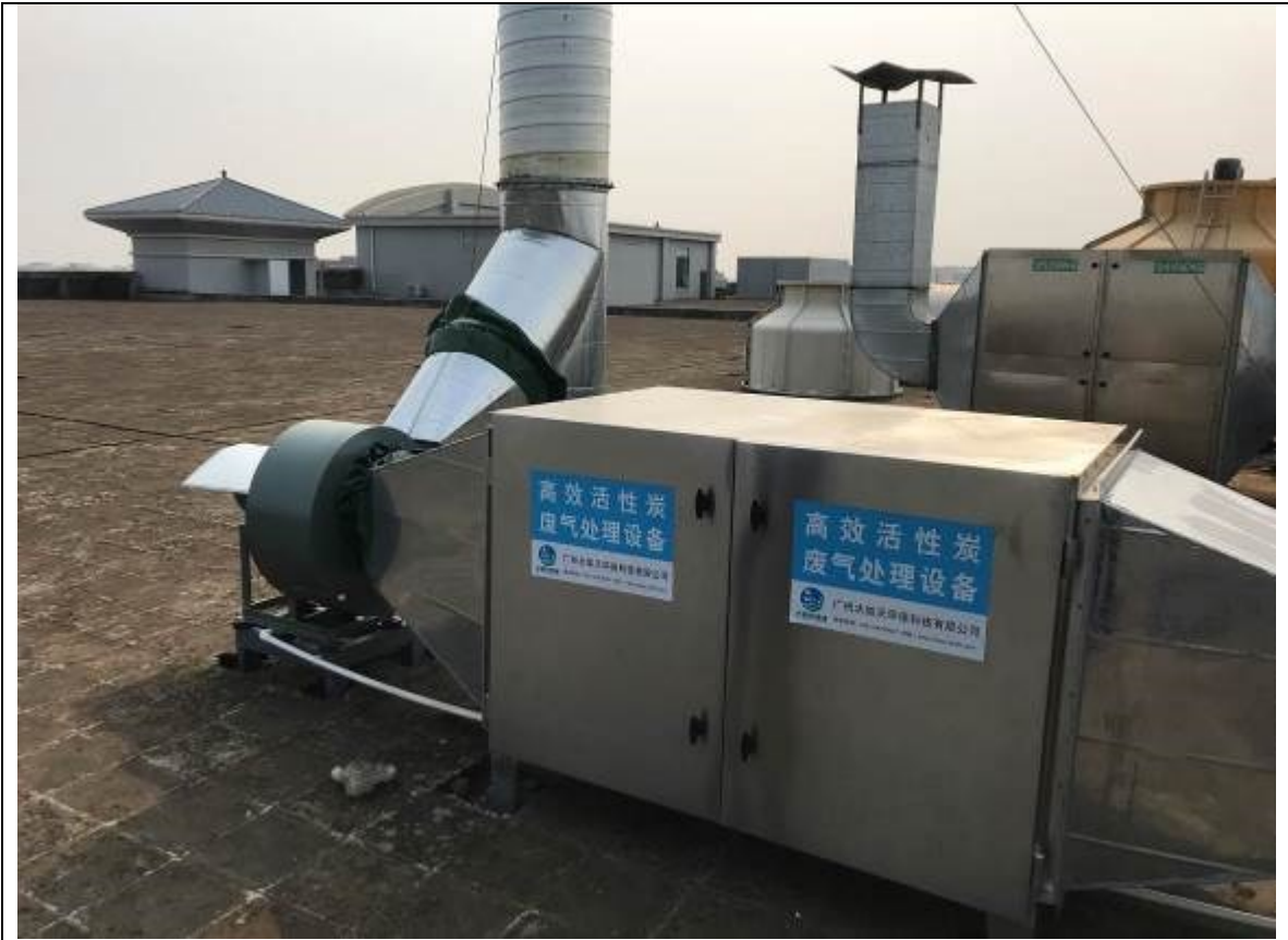
活性炭吸附装置及排气筒
