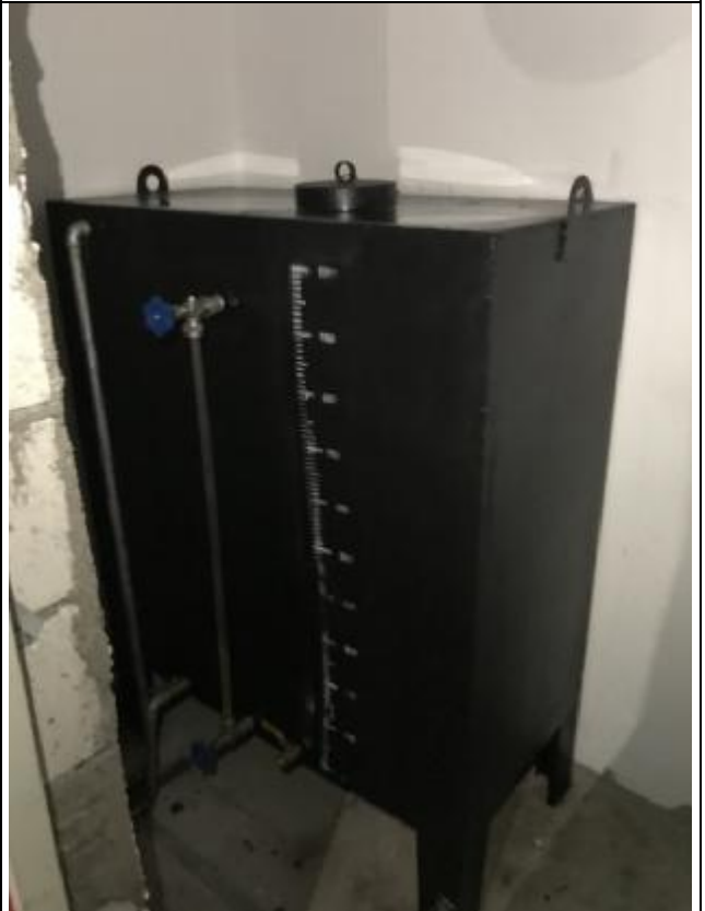
发电机房油箱
