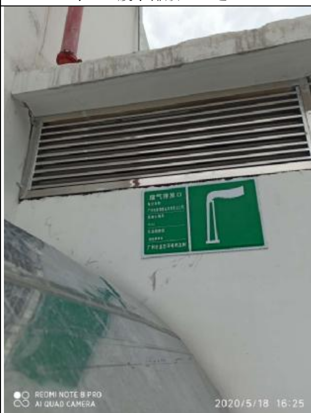
气-01 发电机尾气排放口（远）
