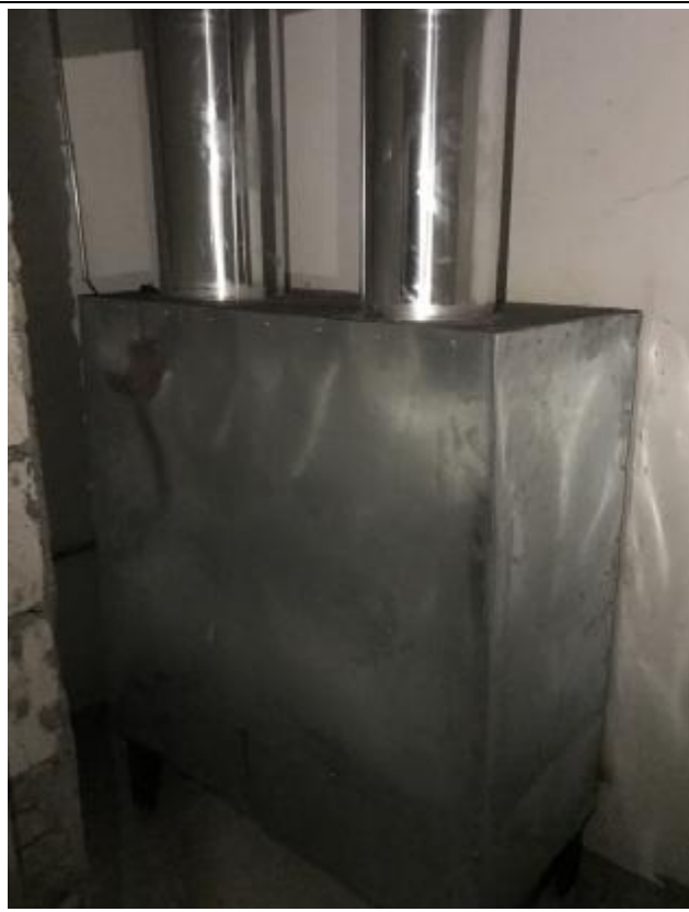
发电机房水喷淋装置
