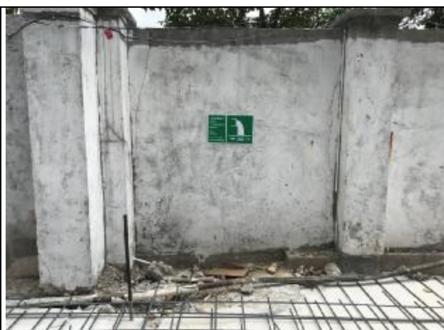
水-01 废水排放口（远）
