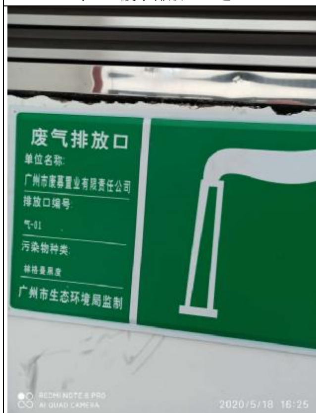
气-01 发电机尾气排放口（近）
