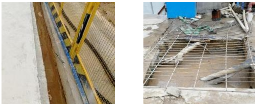
图4.3-1 水土保持临时措施
