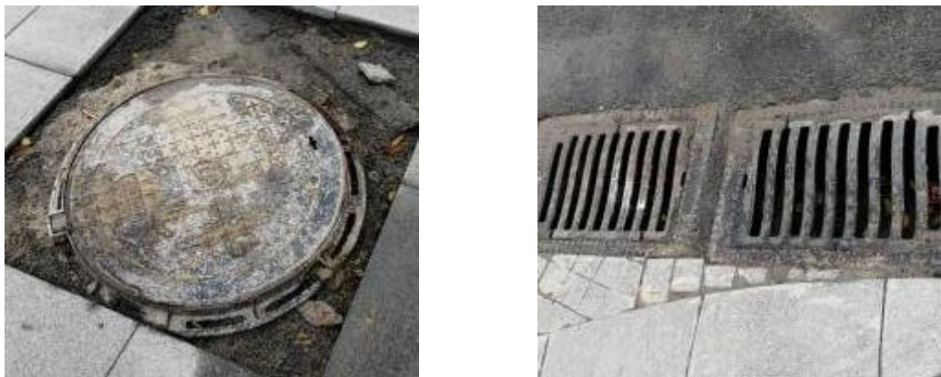
图4.1-1 水土保持工程措施现状
