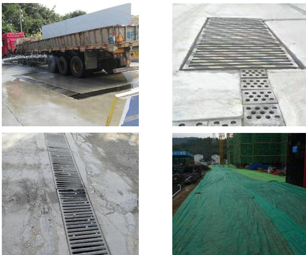
图4.3-1 水土保持临时措施
