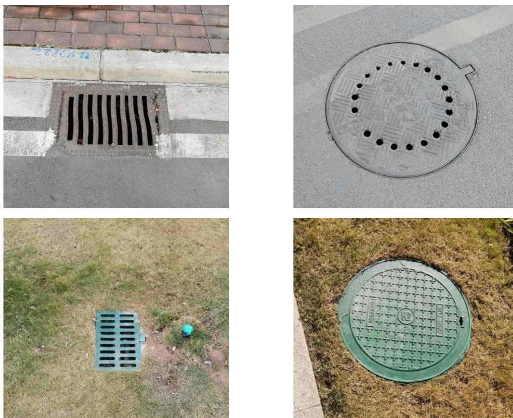
图4.1-1 水土保持工程措施现状
