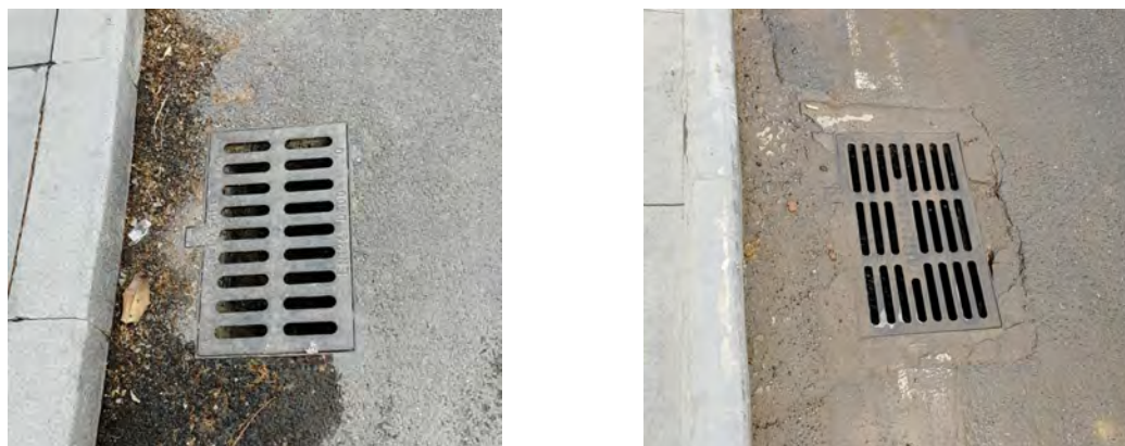
图4.1-1 水土保持工程措施现状
