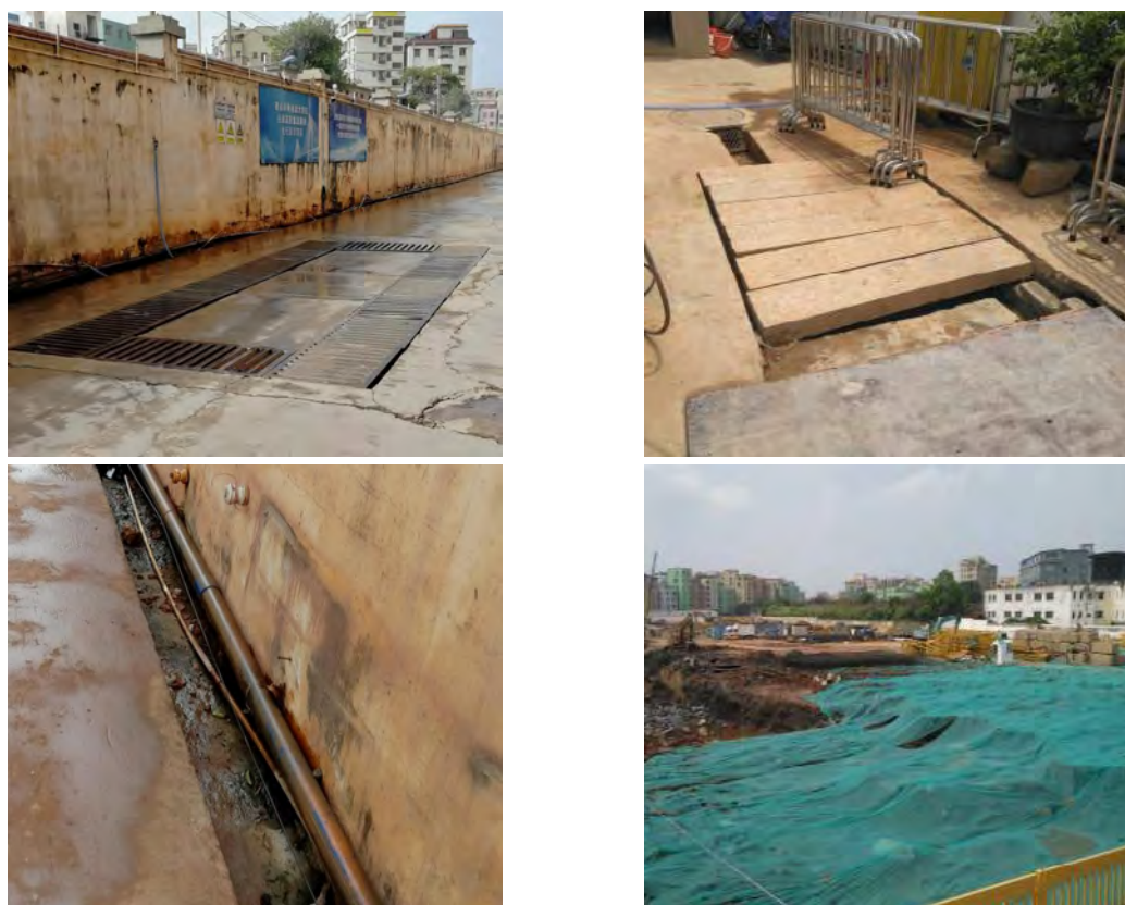
图4.3-1 水土保持临时措施
