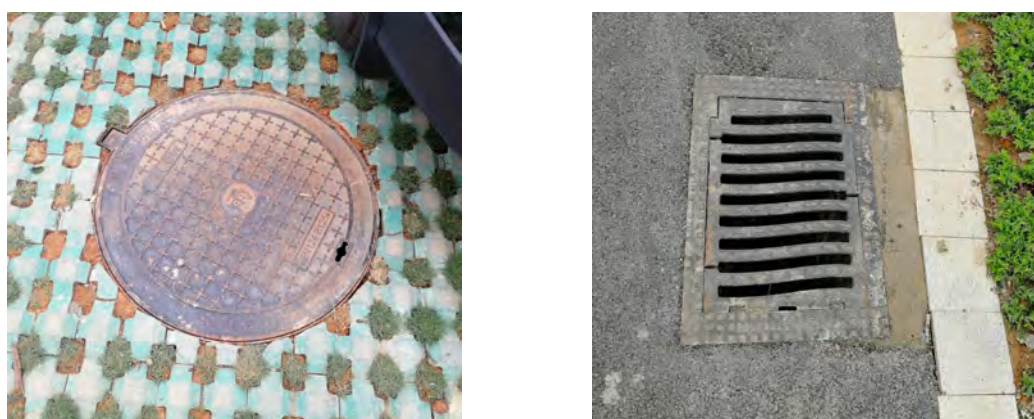
图4.1-1 水土保持工程措施现状
