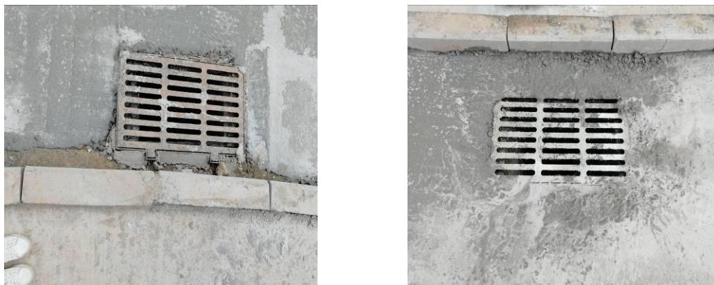
图4.1-1 水土保持工程措施现状
