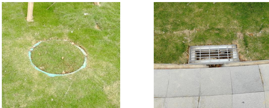
图4.1-1 水土保持工程措施现状
