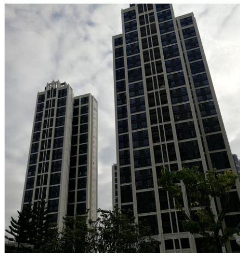
项目建筑物现状2
