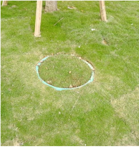
雨水排水设施现状1
