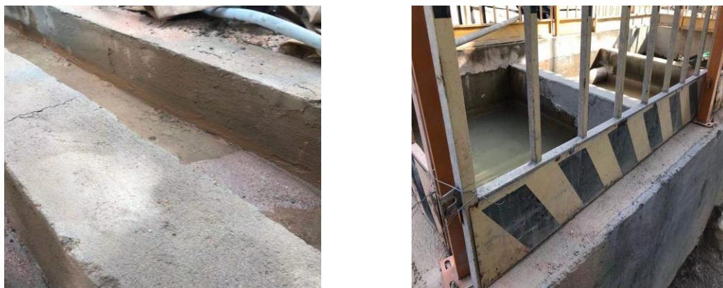
图4.3-1 水土保持临时措施
