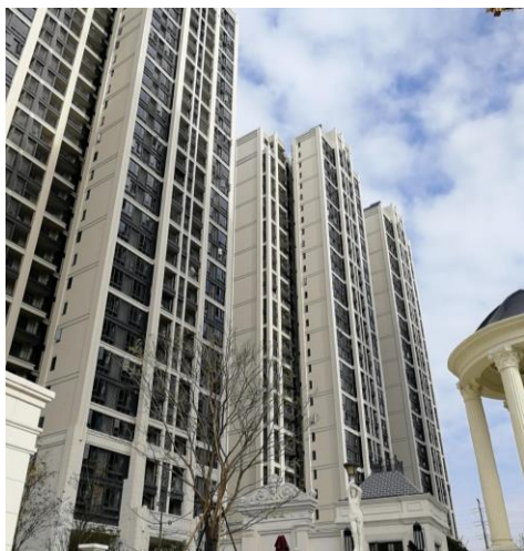
项目建筑物现状1
