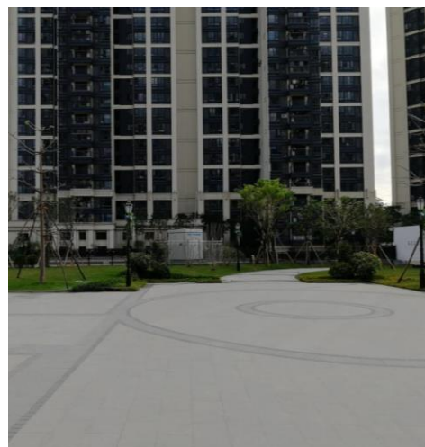
道路广场现状2
