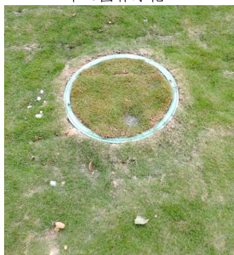
雨水排水设施
