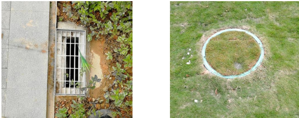
图3.4-1 水土保持工程措施现状
