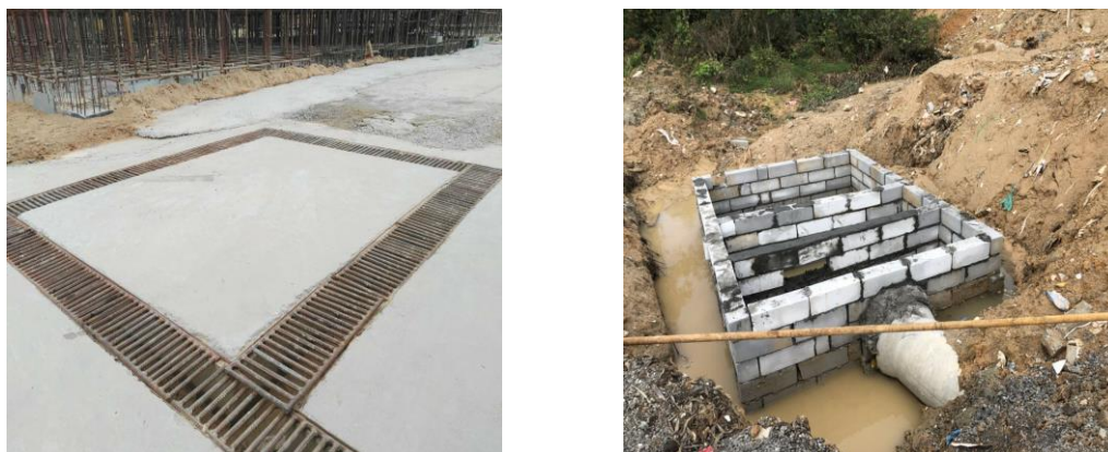
图4.3-1 水土保持临时措施
