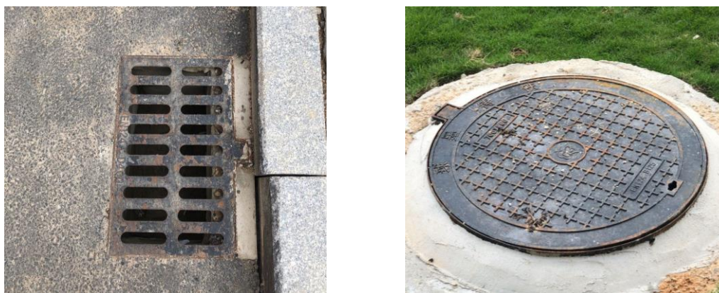
图4.1-1 水土保持工程措施现状
