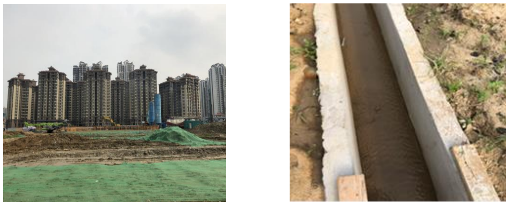
图4.3-1 水土保持临时措施
