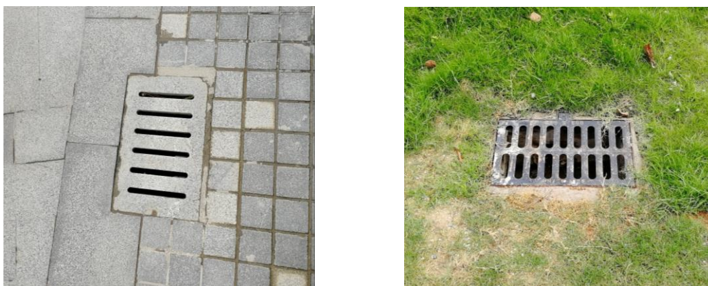
图4.1-1 水土保持工程措施现状
