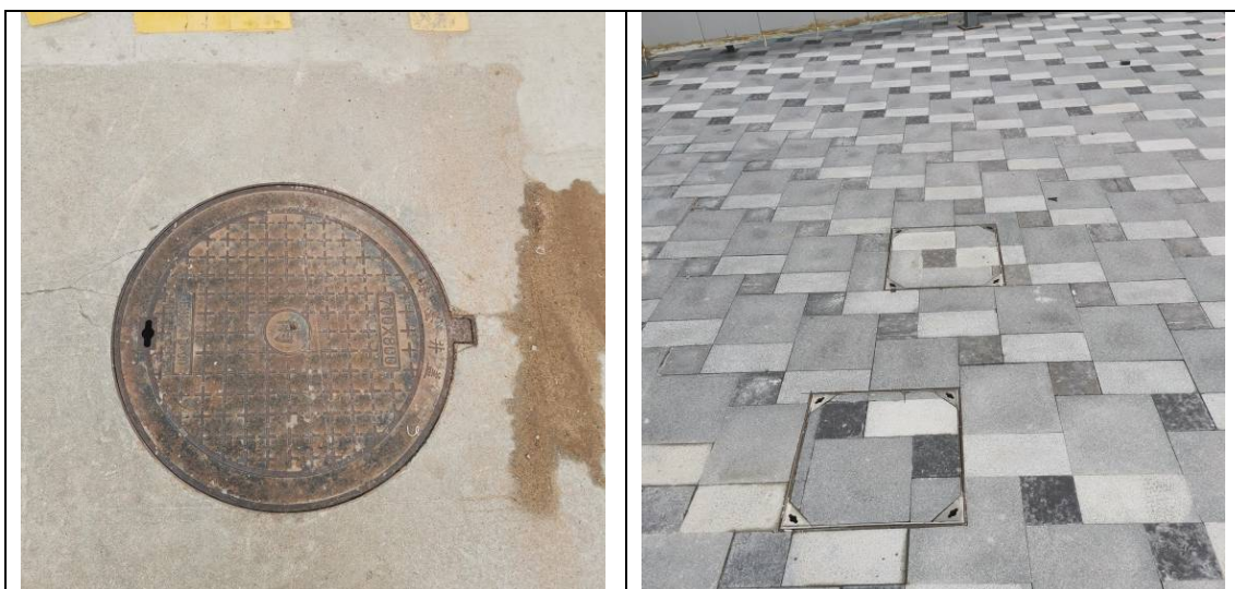
图3.4-1 排水设施现状
