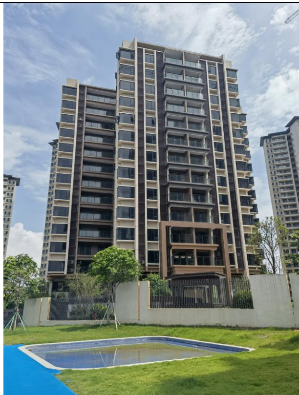
项目现状：3#住宅楼
