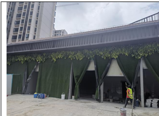
项目现状：2#垃圾收集站
