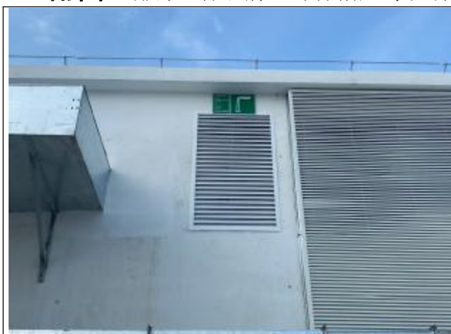
气-01 发电机尾气排放口
