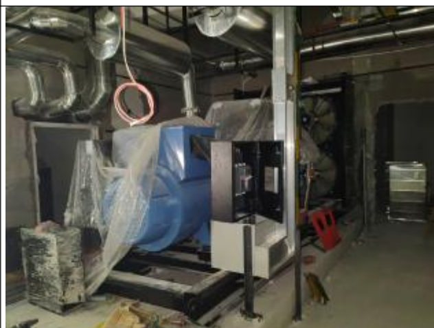
发电机房及备用发电机
