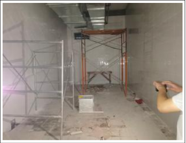
生活垃圾暂存房
