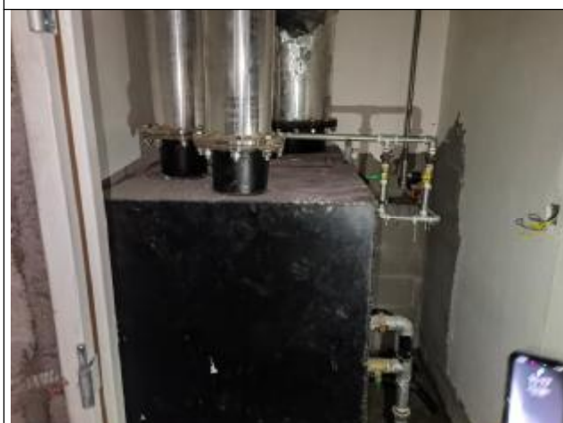
发电机房水喷淋装置
