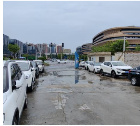
南侧施工临建区现状
