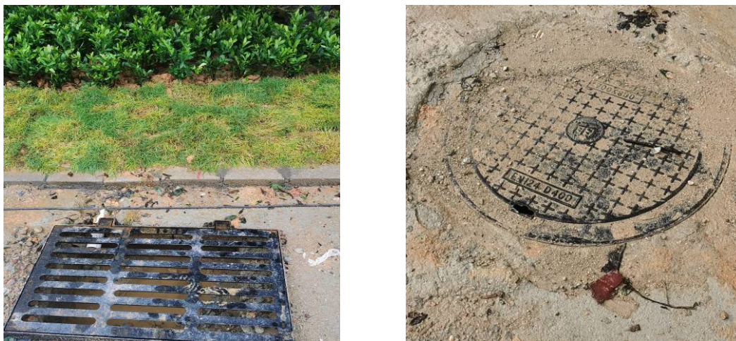
图4.1-1 水土保持工程措施现状
