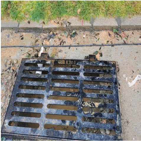
排水管网现状
