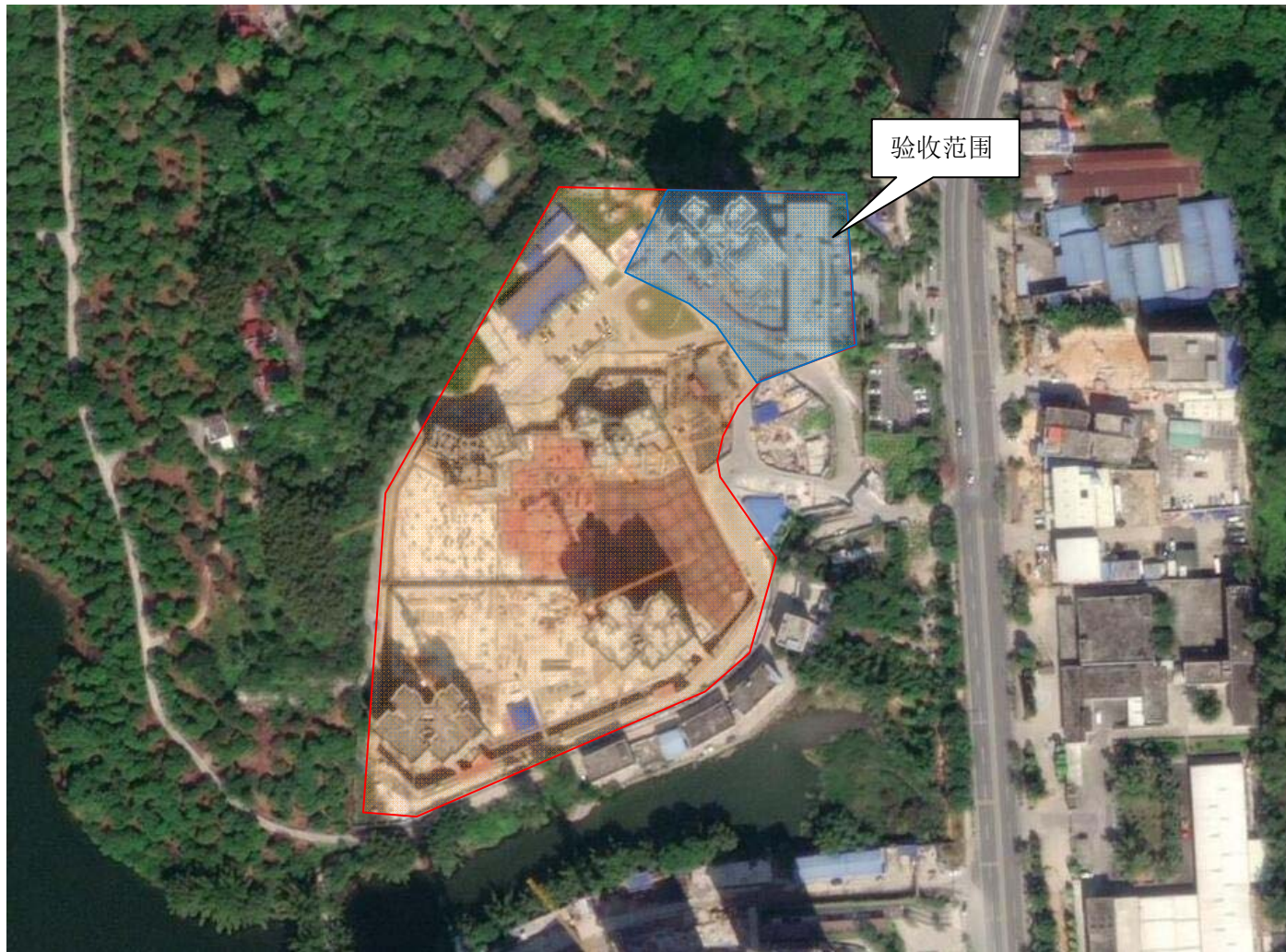
项目建设后遥感影像图（获取于谷歌地图，拍摄时间为2021年5月）
