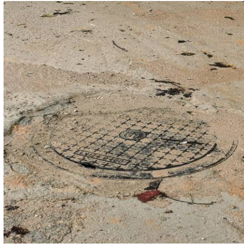
排水管网现状
