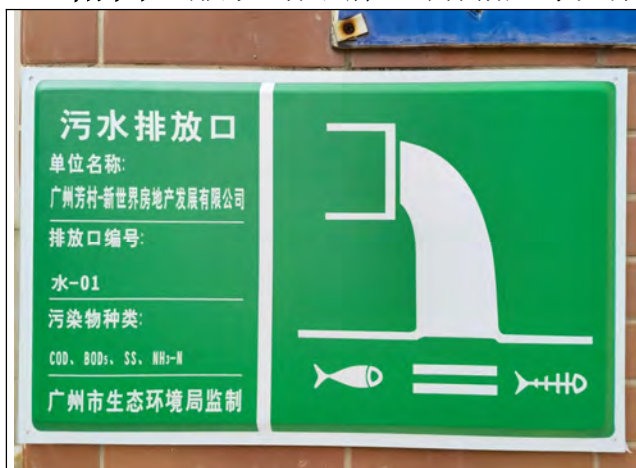
水-01 废水排放口（近）
