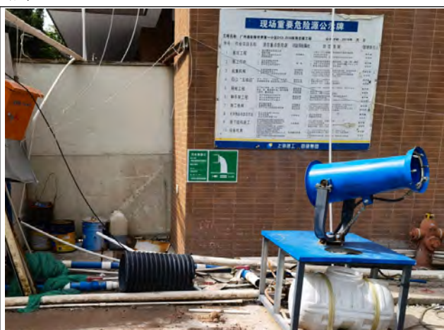
水-01 废水排放口（远）
