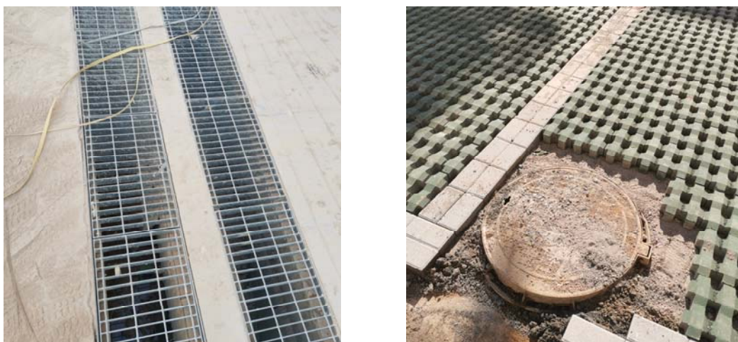
图4.1-1 水土保持工程措施现状
