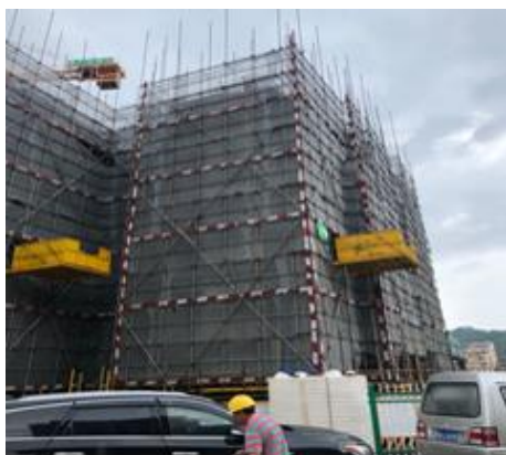
2020年第一季度（6#住宅楼）
