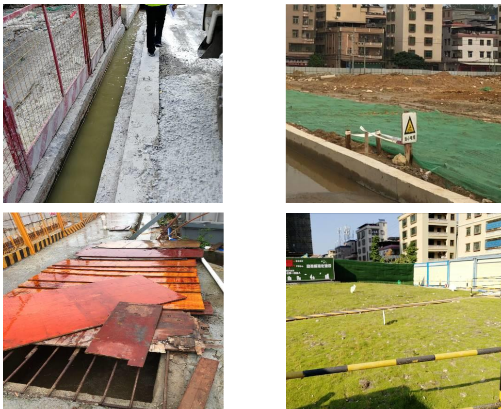
图4.3-1 水土保持临时措施
