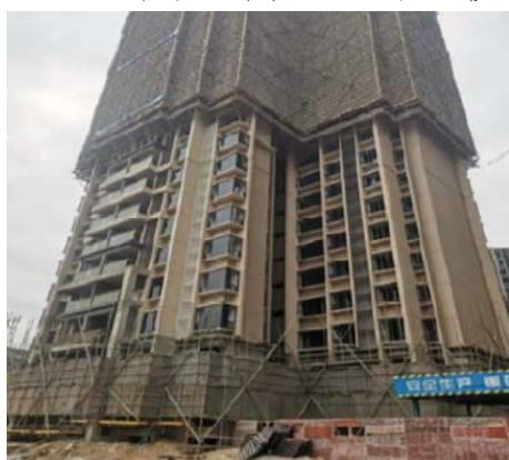
2020年第四季度（10#住宅楼）
