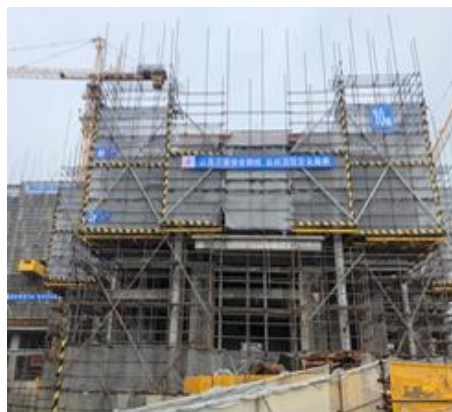
2020年第一季度（10#住宅楼）
