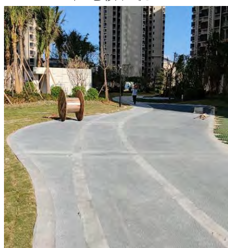
道路广场现状2
