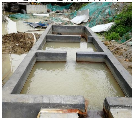
地块DEF沉沙池
