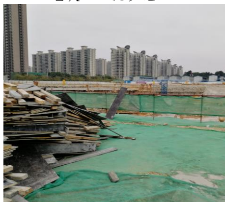
地块DEF临时覆盖
