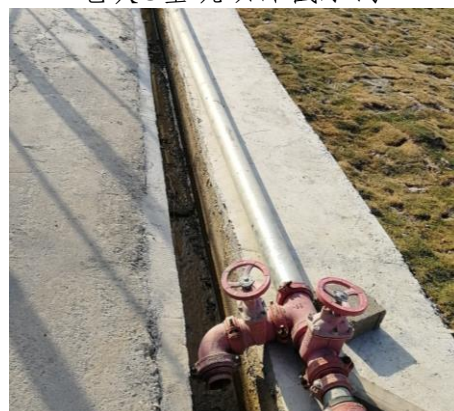
地块DEF临时排水沟
