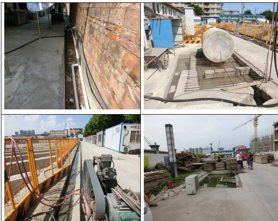
图3.5-3 水土保持临时措施（已拆除）
